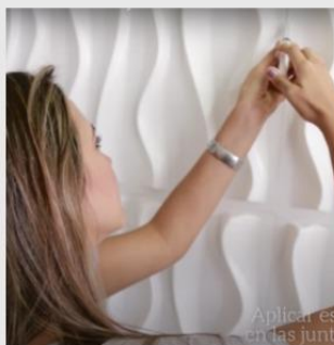
▪ Puedes aplicar estuco plástico en las juntas (opcional).
